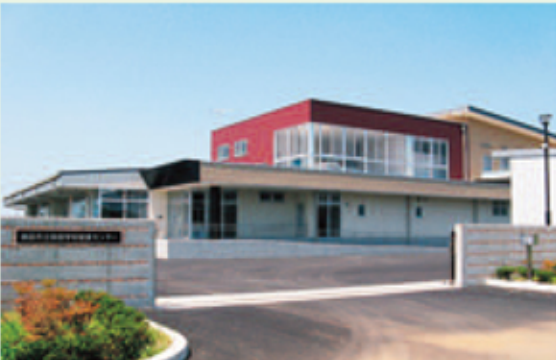
鉾田学校給食センター
