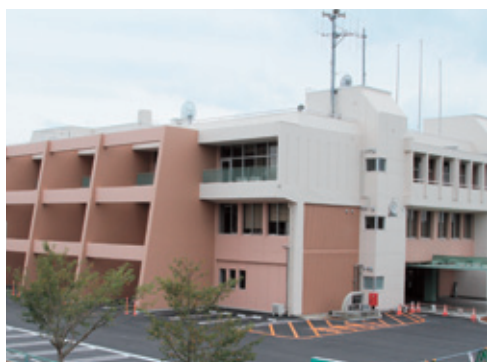
本庁舎耐震補強事業
