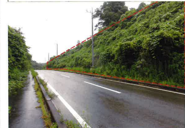
② 県道182号線から敷地を見る
