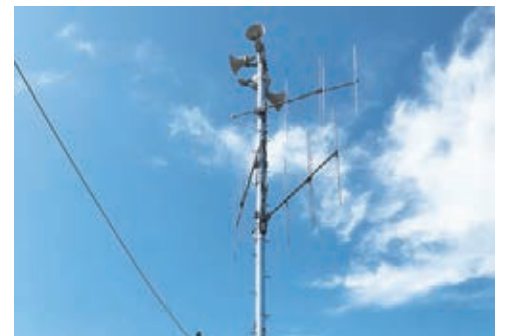
防災無線放送施設デジタル化事業
