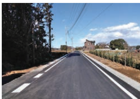
道路整備事業（市道8-359号線 鳥栖地内）
