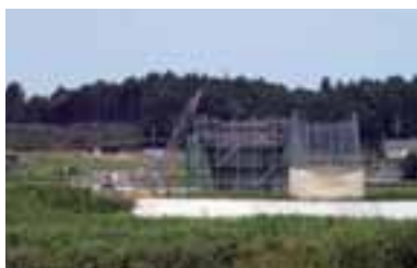
▶平成21年の開通にむけ、工事は茨城町側から進められています（茨城町小鶴の酒沼川付近）
