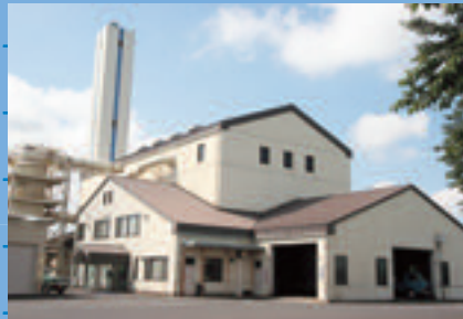
▲ごみ焼却施設補修等整備工事
