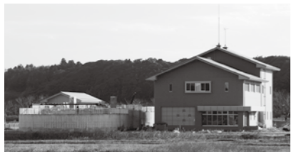
銚田市水処理センター
