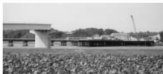
鹿行大橋工事風景
