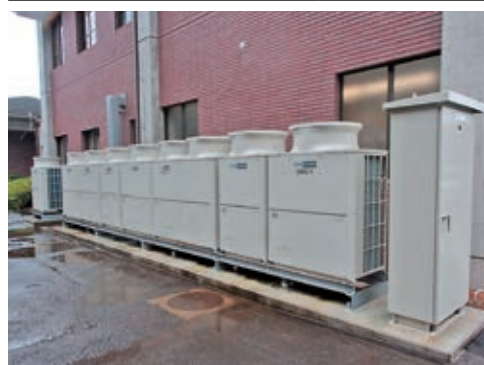
旭総合支所空調工事
