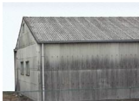
石綿含有スレート波板（屋根・外壁）
