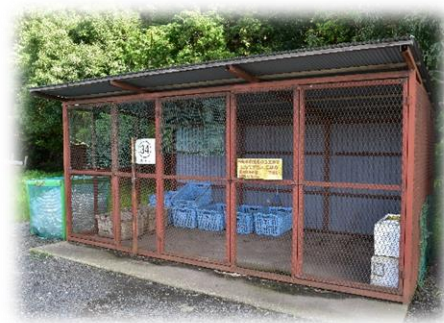
整理整頓されたごみ集積所 (旭地区)
