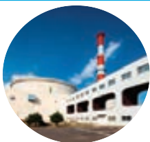
高速実験炉「常陽」
