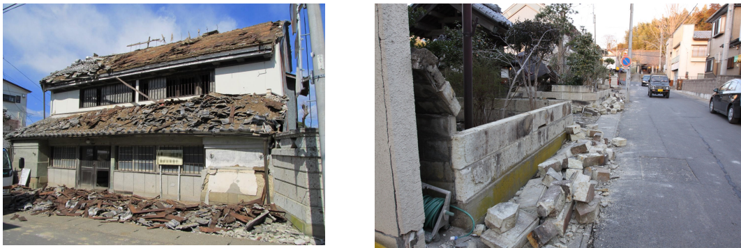
東日本大震災における市内の被災状況
