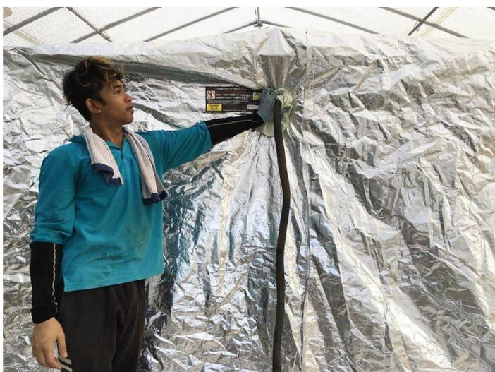
シルバーシートで骨組みを覆い、CO<sub>2</sub> ガスを注入。シート内を CO<sub>2</sub> 濃度約 60%に調整し、その状態を 24 時間キープします。
