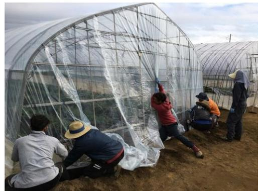
ハウスの長さは 50m。ハウスを被覆するビニールは大変な重さです。とてもひとりでは持ち運ばなく、何名ものスタッフでハウス北端から南端まで引っ張っていきます。かなりの重量と、このビニールはこれから約1年使用するためずれのないよう慎重に作業をしていく必要があります。一方で、少しでも風が吹くと 50m のビニールが煽られて作業が中断します。風の無いタイミングで迅速に進めていかなければなりません。
